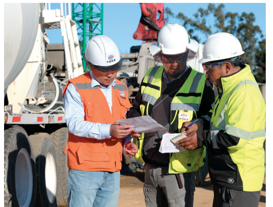
4月29日,在智利皮奇莱穆医院项目施工现场,奥伊金斯大区医疗网络项目经理张金涛(左)与同事交流。新华社记者 周佳宜摄
