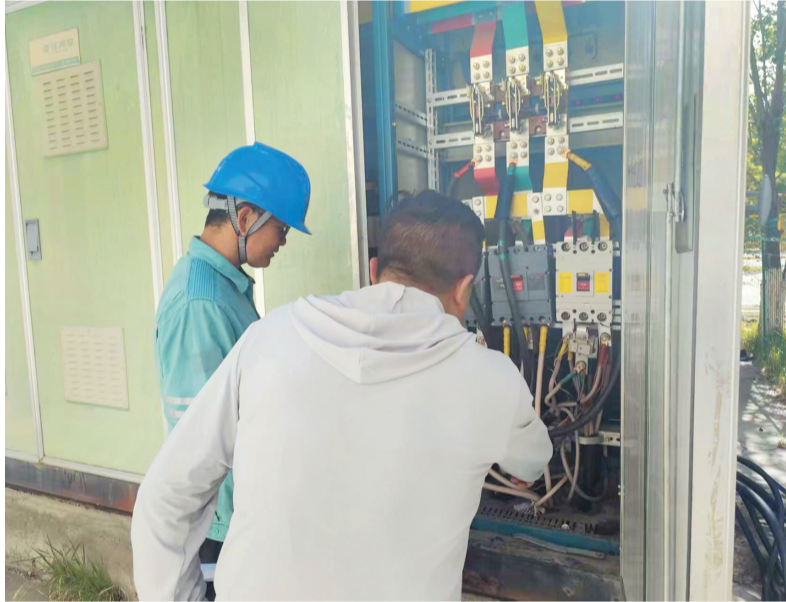
图为在拉萨阿里地区高级中学考点,国网拉萨供电公司工作人员和考点工作人员对高考用电线路进行检查。 拉萨融媒记者 齐永昌摄
